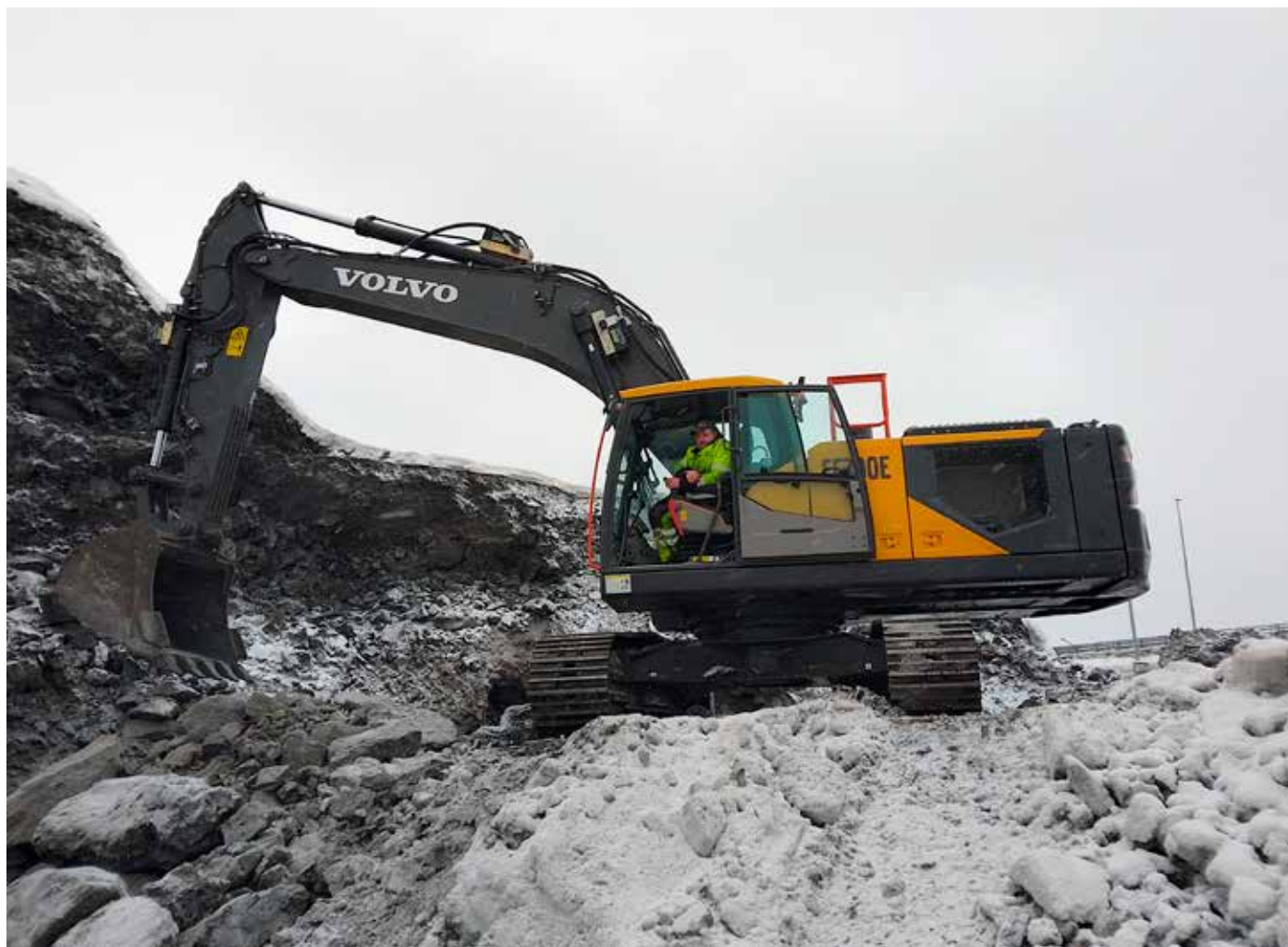
Infran työmaalla on koekäytössä Norrhydron ja Volvon kehittämä tela-alustaisen työkonteen prototyyppi digitaalisella hydraulikkajärjestelmällä, jonka uskotaan vähentävän merkittävästi työkonteen polttoainekustannuksia ja CO 2 -päästöjä sekä leikkaavan huomattavasti koneen käytön aiheuttamaa hiilijalanjälkeä. Kuva Juulia Puukari.
